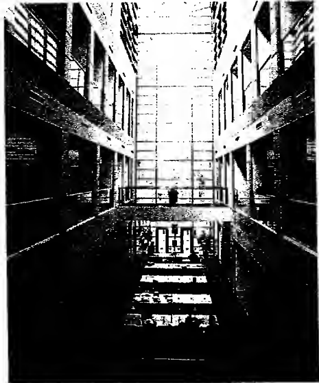
صورة (٢٦٩): منطقة قراءة في مكتبة حكومية لاحظ عدم تأثر المنطقة بأشعة الشمس نظراً لاستخدام زجاج يشتمل الأشعة
